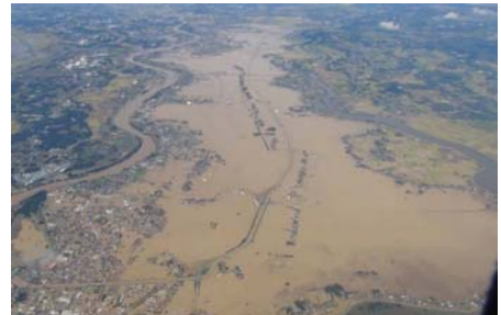
茨城県常総市の浸水状況
