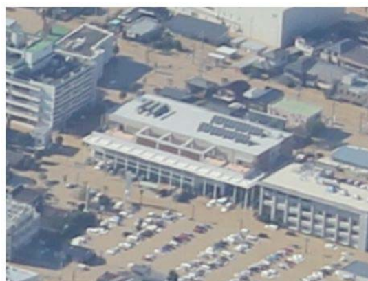
茨城県常総市役所の浸水被害
