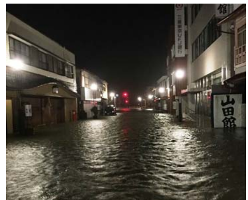
伊勢神宮外宮前の浸水状況（三重県）
