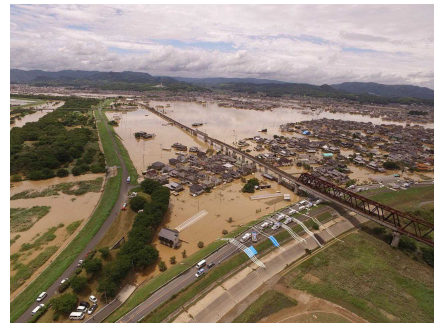
岡山県倉敷市真備町の浸水及び排水状況
