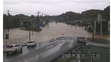
国道 10 号線の冠水状況(宮崎県宮崎市富吉付近)
