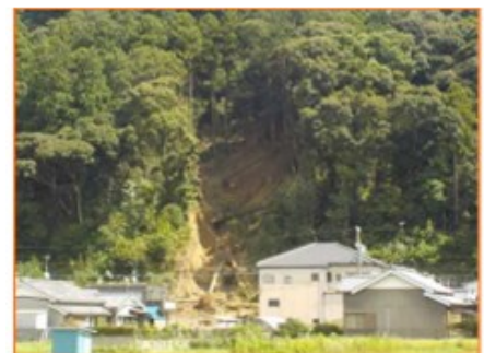
静岡県磐田市平松で発生したがけ崩れ （静岡県磐田市）
