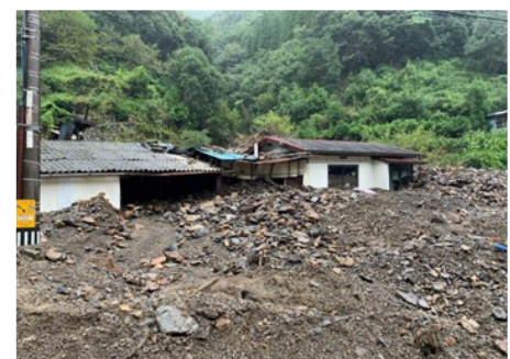
台風第14号による土石流 にしめら （宮崎県西米良村）
