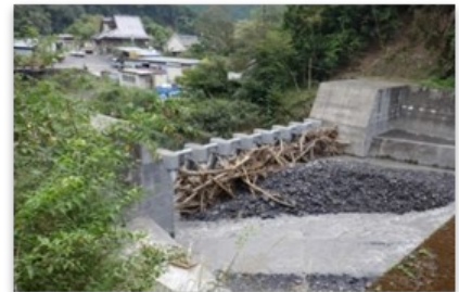
静岡県静岡市葵区入島で発生した 土石流等（静岡県静岡市葵区）
